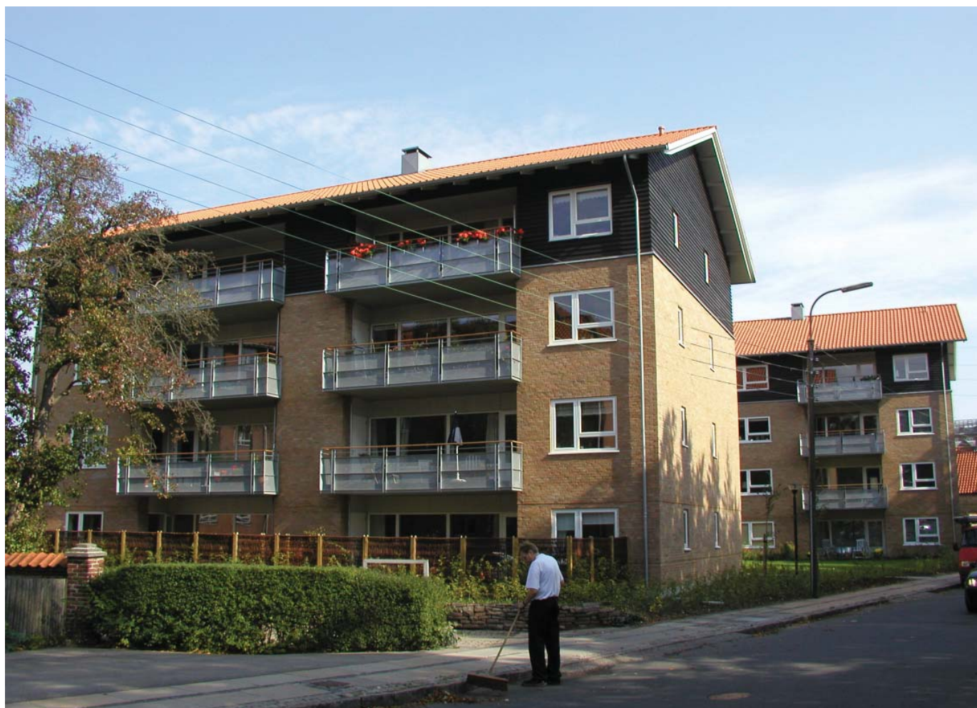
24 andelslejligheder i 4 etager. Bygherre: Markol A/S Opført af MTHøjgaard A/S
