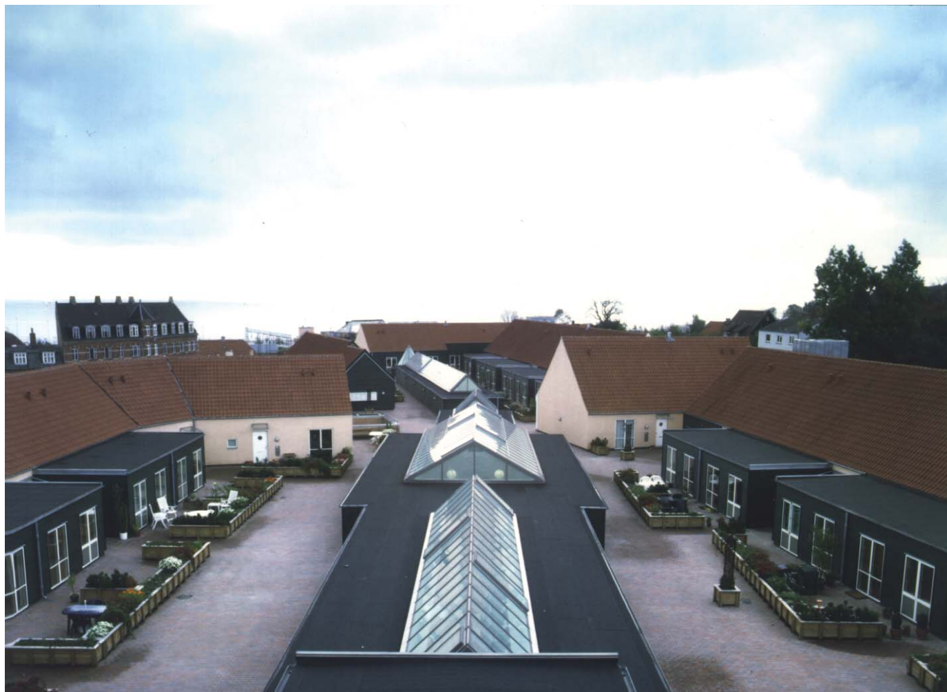
26 pensionskasseboliger på toppen af Helsingør Bycenter med udsigt over Øresund. Bygherre: Værkstedsfunktionærernes Pensionskasse A/S Opført af MTHøjgaard A/S
