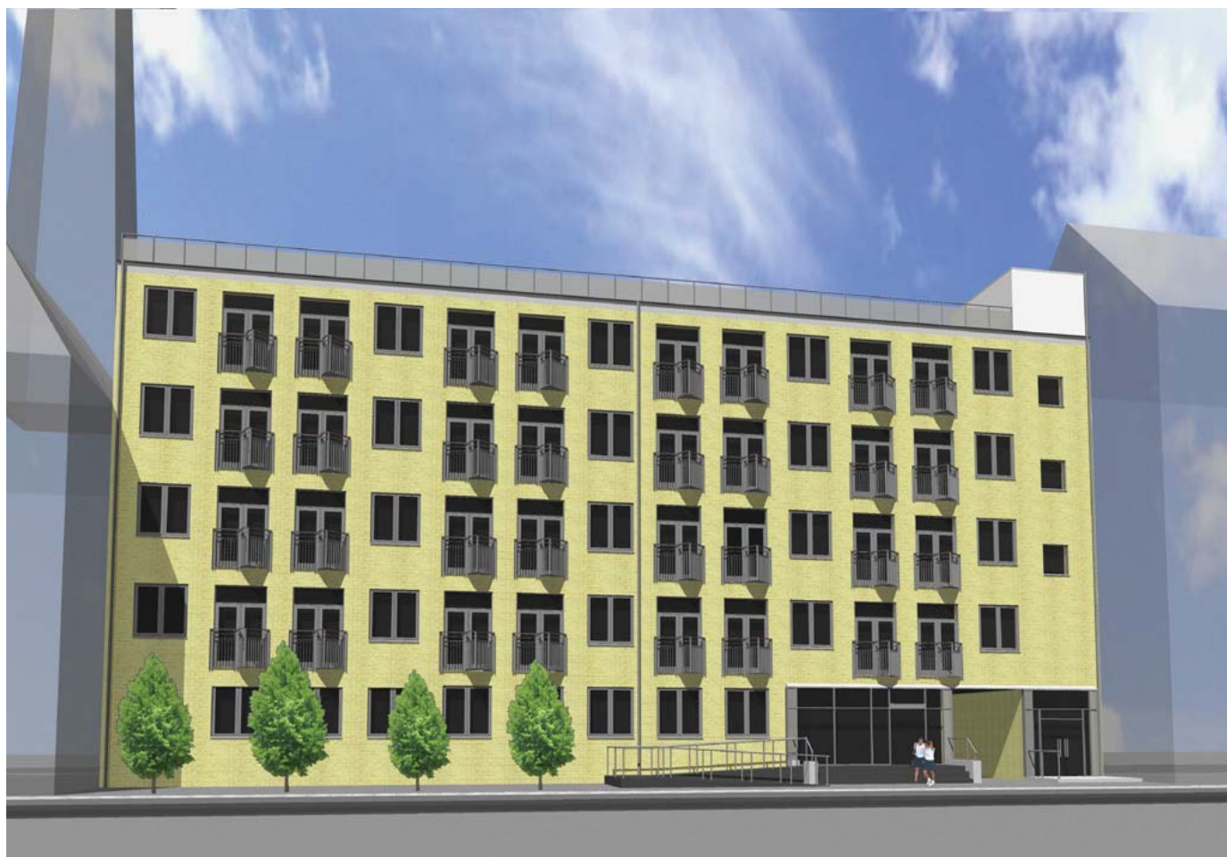
62 Ungdomsboliger indrettes i eksisterende administrationsbygning. Bygherre: Wihlborgs A/S
