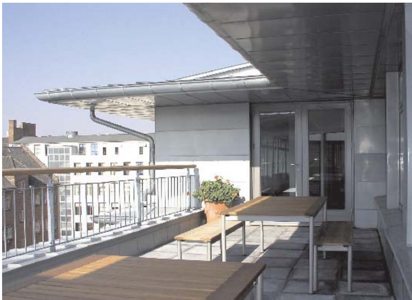
Ny tagetage på eksisterende administrationsbygning på 2000 m 2 . Ombygning af eksisterende kontorer. Bygherre: Danske Energiselskaber Totalentreprenør: MTHøjgaard A/S
