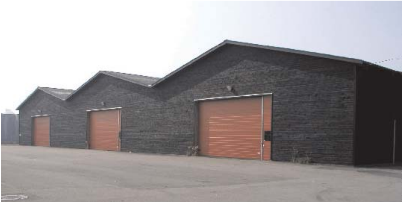
Om- og tilbygning af lagerhaller, administration og kantine. Præmieret af Hvidovre Kommune i 2002. Bygherre: Danske Trælastkompagni A/S Opført af MTHøjgaard A/S
