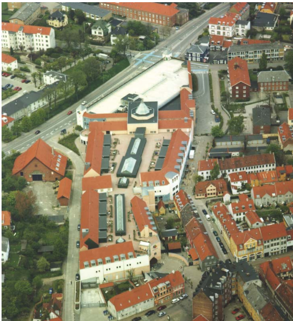
Butikcenter med tilhørende parkeringshus og administration på i alt 38000 m 2 . Bygherre: Foras Totalentreprenør MTHøjgaard A/S
