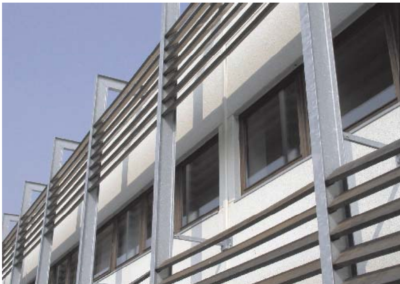
Lager og administrationsbygning på i alt 4700 m 2 . Bygherre: Danske Trælastkompagni A/S Totalentreprenør: MTHøjgaard A/S
