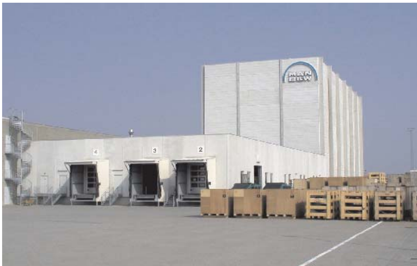
Højlager og almindelig lagerbygning. Henholdsvis 1260 m 2 i 26 meters højde samt 1400 m 2 i 7,5 meters højde. Bygherre: MAN B&W Diesel Totalrådgiver: Leif Hansen A/S
