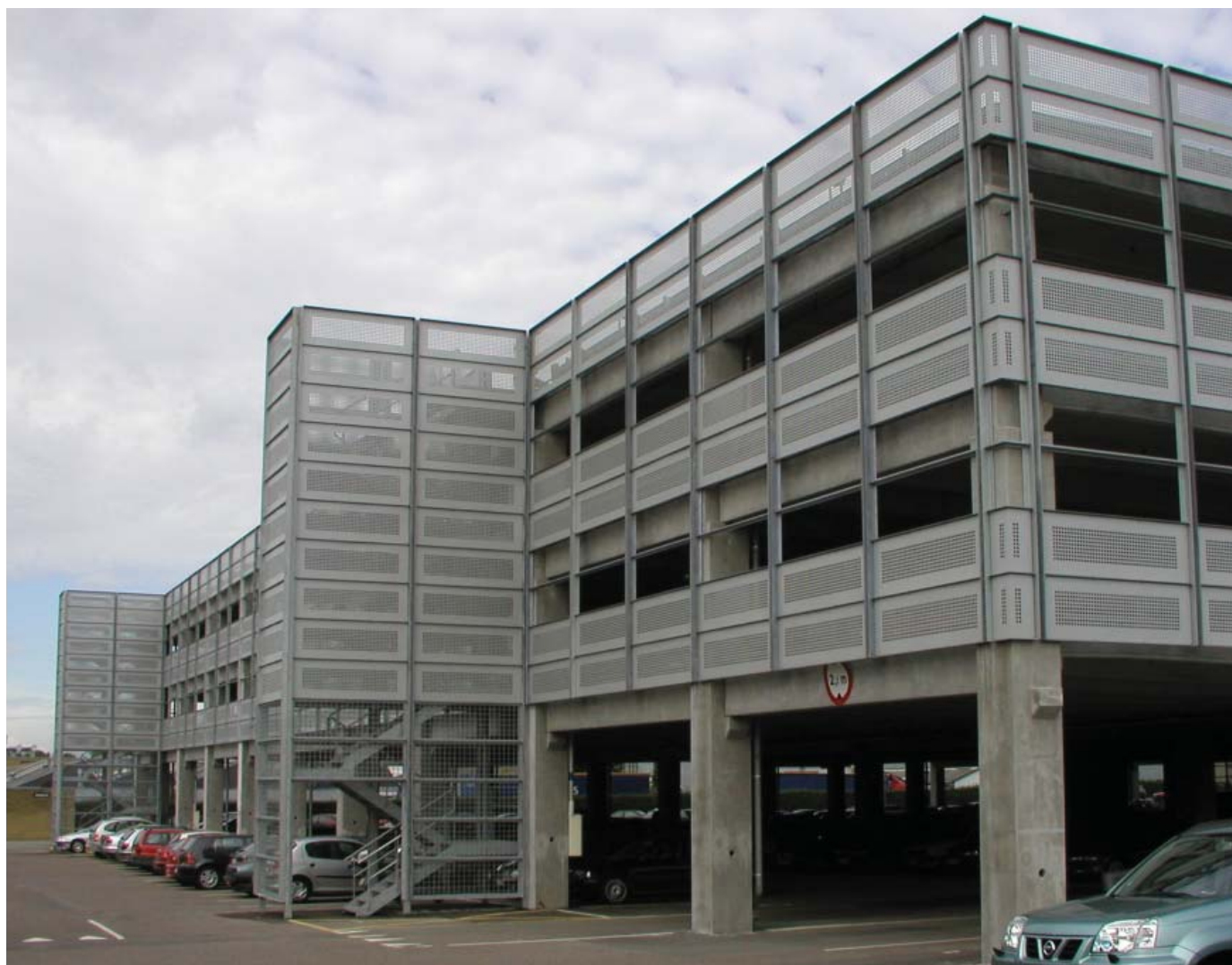
Nyt parkeringshus til 1400 biler. Bygherre: Novo Nordisk A/S Opført af MTHøjgaard
