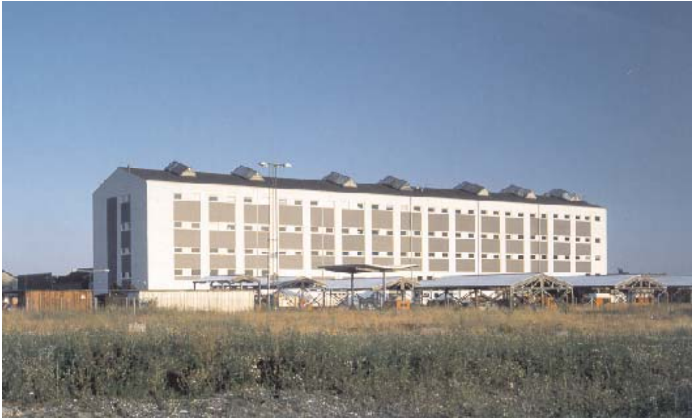
Facaderenovering af erhvervsejendom. Bygherre: KTAS Pension Totalentreprenør: NCC A/S
