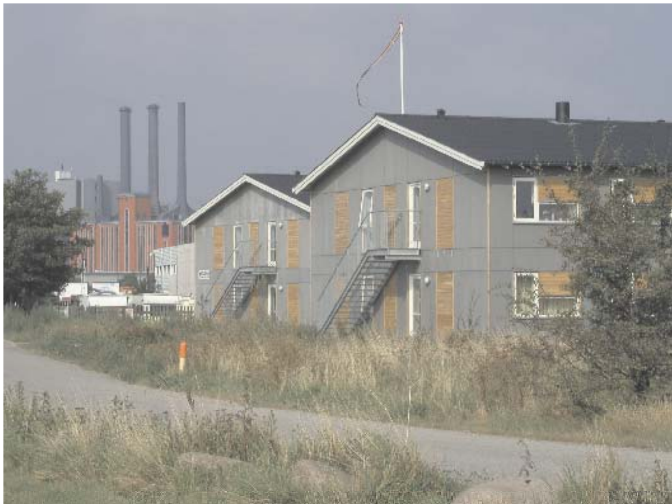
Herberg med 48 lejligheder i to etager. Bygherre: KFUM's sociale arbejder Totalentreprenør: NCC
