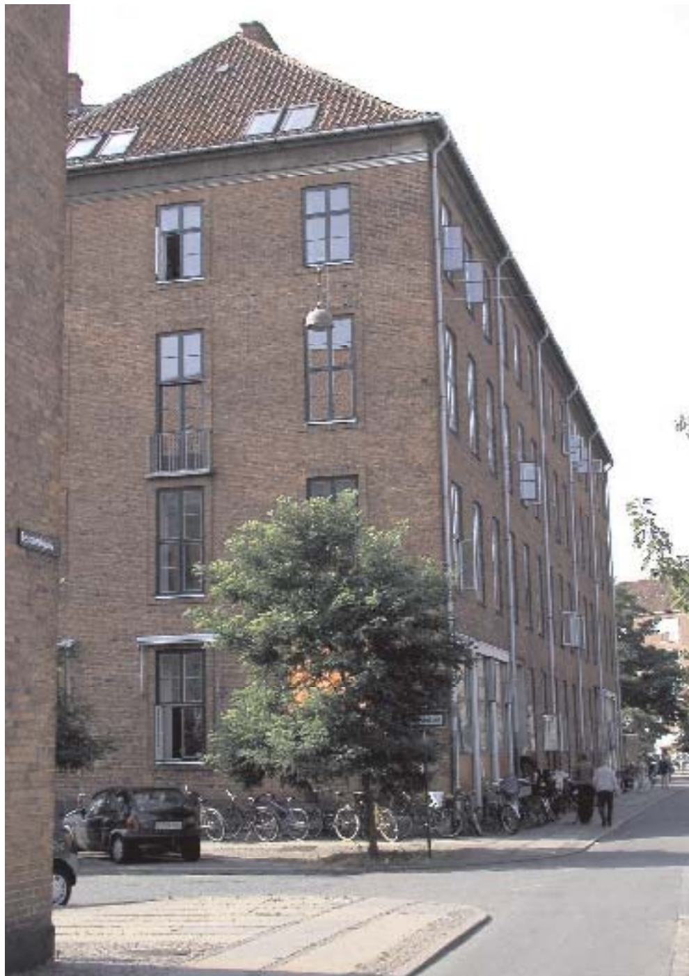
Vinduesudskiftning af 900 vindueselementer Bygherre: Københavns Kommune
